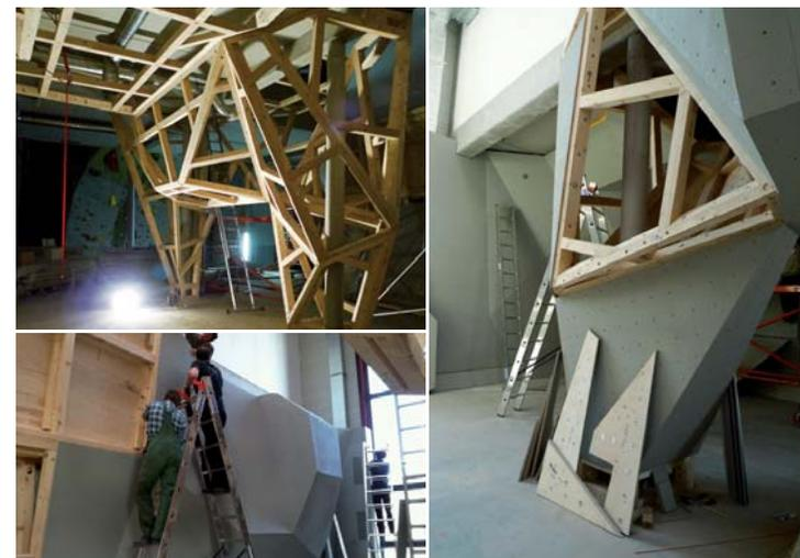
Boulder in Fachwerkbauweise, beplankt mit Quarzsand-beschichteten Furnierschichtplatten. Komplett Montage der Vorfertigung durch Vereinsmitglieder.
