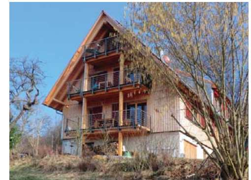
Neubau Wohnhaus Michelstadt, Holzbauweise
