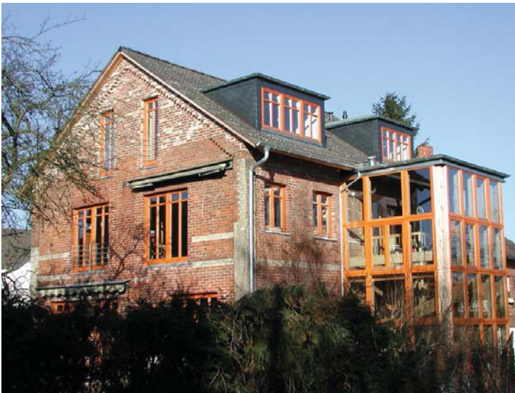
Sanierung und Dachausbau eines Wohnhauses Bj. 1902; Lehm, Holz; (bei Peine)
