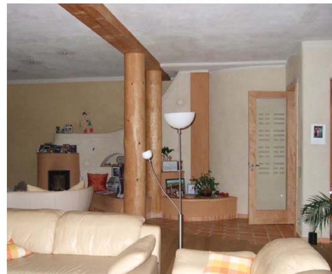
Neubau, Holzrahmenbau: Grundofen zur Beheizung von EG und OG, Mondphasenholz, Lehmbautechniken (bei Hannover)
