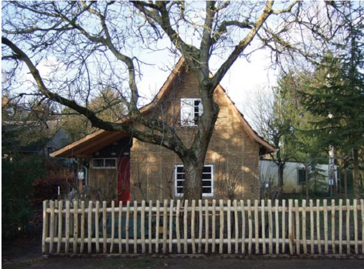
Sanierung und Anbau in Lehmbautechnik; „Stampflehmhaus“ Bj. 1950, (bei Celle)
