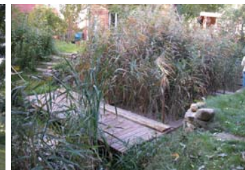
Pflanzenkläranlage in 14109 Berlin (D)
