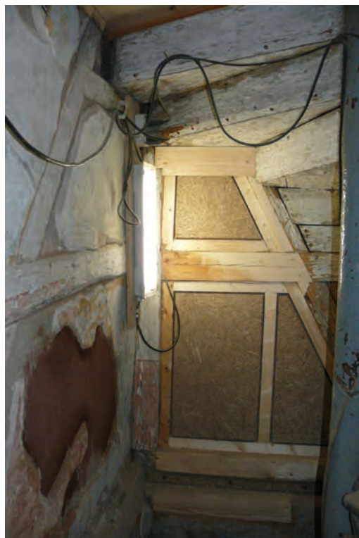
Ausfachung der Kommunwand mit Typha-Platten, Foto Helmut Knodt
