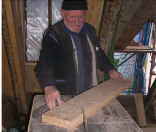
Zuschneiden der Typha-Platte, Foto Alexandra Fritsch
