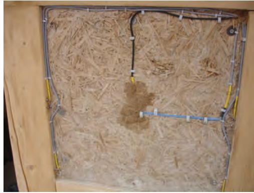
Bild 16: Äußere Sensorik an der Grenzsicht 1, unterhalb des Außenputzes, Foto IBP
