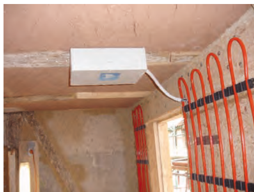
Bild 19: Ansicht der provisorischen Montage des Gerätekastens sowie der bereits aufgebrachten Wandflächenheizung im August 2010, Foto IBP
