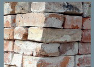
Holzschindeldeckung und Altbauziegel zur Wiederverwendung
